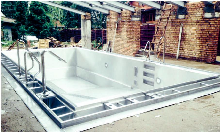
Бассейны Аквасектор изготавливаются на заказ в заводских условиях и затем монтируются на объекте.
